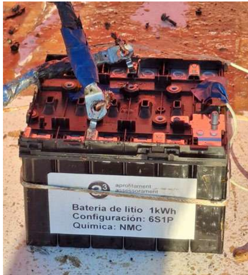
Figura 20: Estado de la batería antes del ensayo 3.
